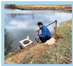
▲ 岩瀬地域 安全確保と安定した水管理のため、ため池種の修繕工事を実施
